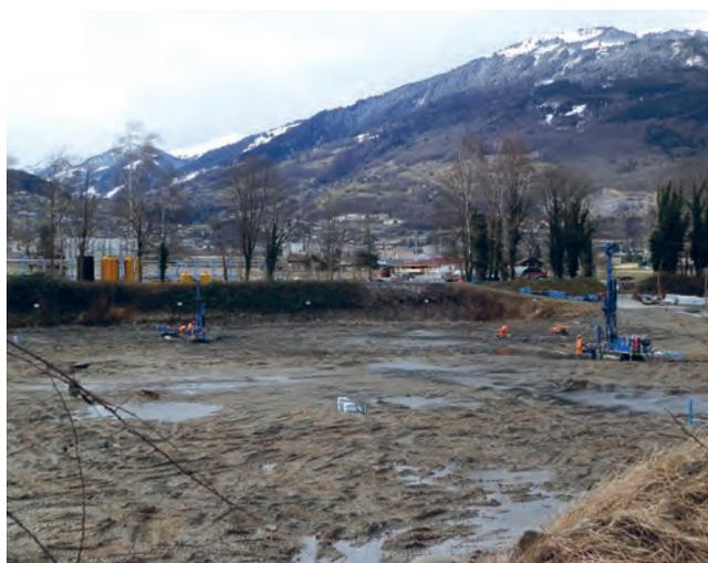
▶ Durant la 1<sup>re</sup> étape de l'assainissement, l'étang a été asséché. Les boues ont été pompées avant d'excaver mécaniquement des terres sur les berges et dans le fond de l'étang. (CIMO/DR)
